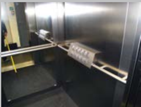
✓ Disposition correcte des boutons à l'intérieur de la cabine
