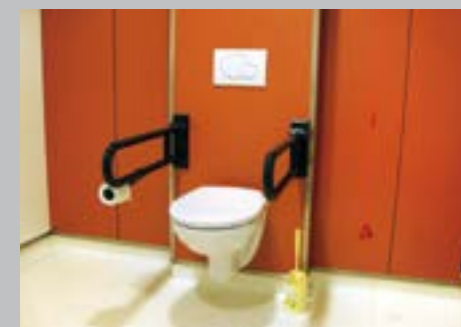
✓ Toilette adaptée disposant de 2 aires de transfert
