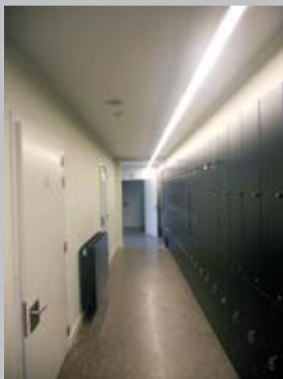
✓ Éclairage servant de ligne guide
