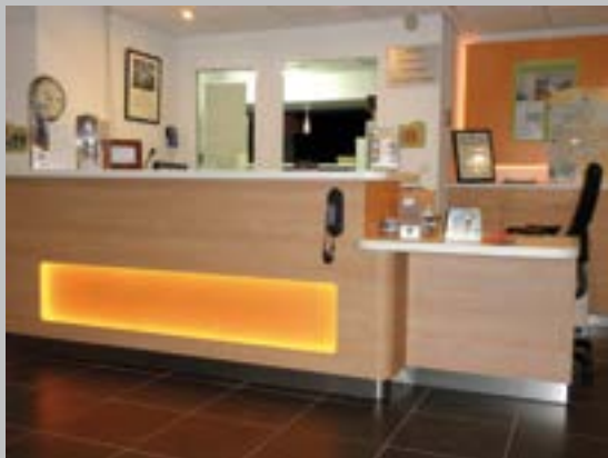
✗ Tablette surbaissée trop peu profonde
