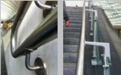
✓ Attache non gênante ✗ Attache gênante
