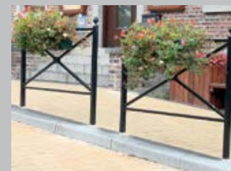
✔ Barrière contrastée et hauteur conforme
