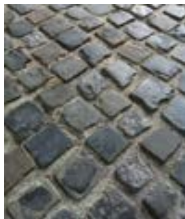
✗ Pavés bombés avec joints creux
