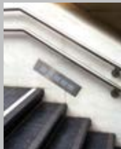
✓ Attache non gênante ✗ Attache gênante
