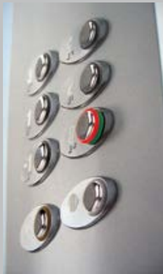
✓ Repères tactiles sur boutons d'ascenseurs
