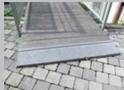
✗ Ressaut au départ de la voie d'accès
